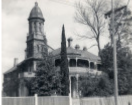
B1562 514 Orrong Rd Armadale
