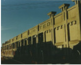
B4710 Dennys Lascelles Concrete Woolstore
