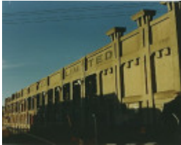
B4710 Dennys Lascelles Concrete Woolstore
