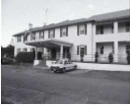
B6989 Erskine House
