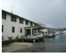
B6989 Erskine House
