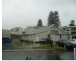
B6989 Erskine House
