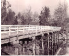
B6924 Wodonga Creek Stockbridge
