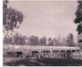
B6924 Wodonga Creek Stockbridge
