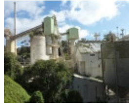
Site view 2017.jpg
