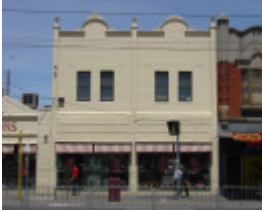
Bridge Rd 490-492.JPG
