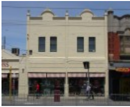
Bridge Rd 490-492.JPG
