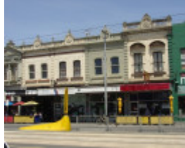
Bridge Rd 376-382.JPG
