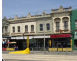
Bridge Rd 376-382.JPG
