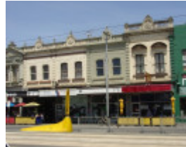
Bridge Rd 376-382.JPG
