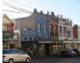
Bridge Rd 4103.JPG
