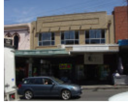
Bridge Rd 204-206.JPG
