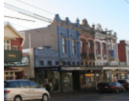
Bridge Rd 4103.JPG
