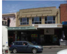
Bridge Rd 204-206.JPG
