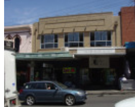
Bridge Rd 204-206.JPG
