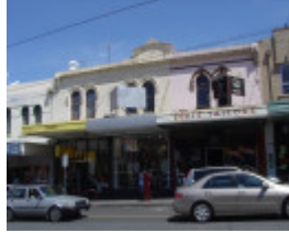
Bridge Rd 208-212.JPG
