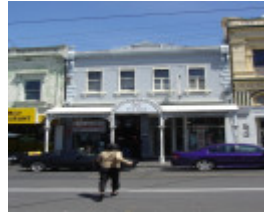
Bridge Rd 186-188.JPG
