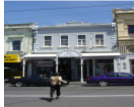
Bridge Rd 186-188.JPG
