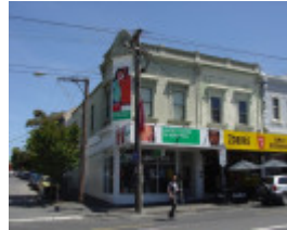
Bridge Rd 190-192.JPG
