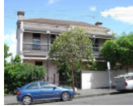
Richmond Docker Street 16- 18.JPG
