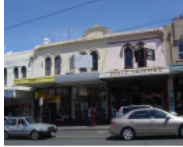
Bridge Rd 208-212.JPG
