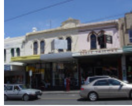
Bridge Rd 208-212.JPG
