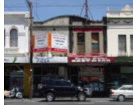
Bridge Rd 354-356.JPG
