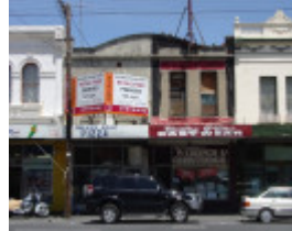
Bridge Rd 354-356.JPG
