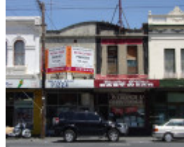
Bridge Rd 354-356.JPG
