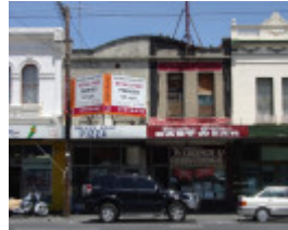
Bridge Rd 354-356.JPG
