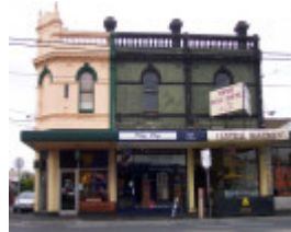
Bridge Rd 2776.JPG
