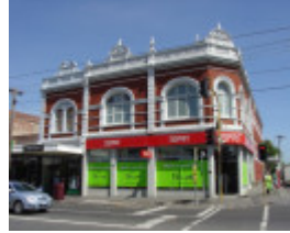
Bridge Rd 132-134.JPG
