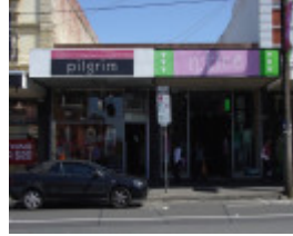
Bridge Rd 136-136A.JPG
