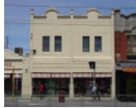
Bridge Rd 490-492.JPG
