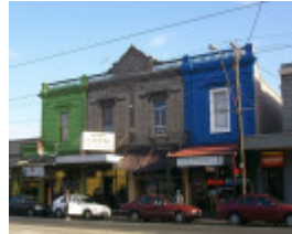
Bridge Rd 400 18239.JPG
