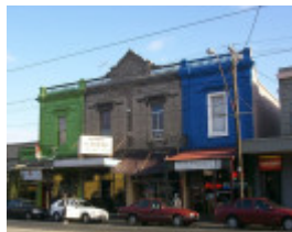
Bridge Rd 400 18239.JPG
