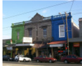
Bridge Rd 400 18239.JPG
