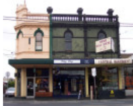
Richmond Bridge Rd 418 2776.JPG
