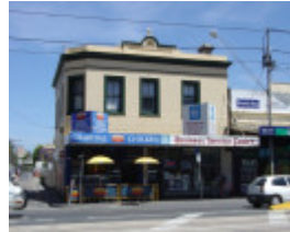
Bridge Rd 310-312.JPG
