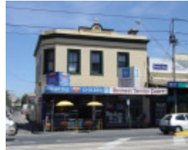
Bridge Rd 310-312.JPG
