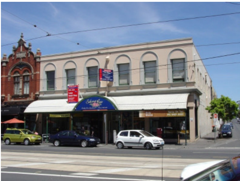
Bridge Rd 290-292A.JPG
