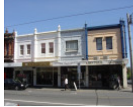
Bridge Rd 102-106.JPG
