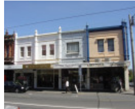
Bridge Rd 102-106.JPG
