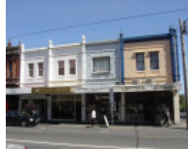
Bridge Rd 102-106.JPG
