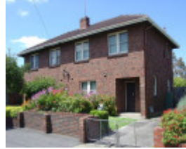
Bridge Rd 618-620.JPG
