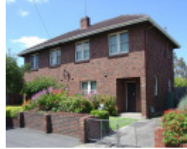
Bridge Rd 618-620.JPG
