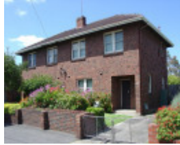
Bridge Rd 618-620.JPG
