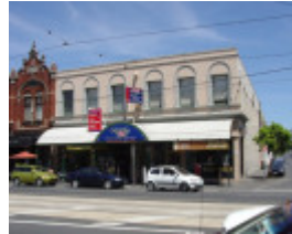
Bridge Rd 290-292A.JPG
