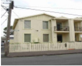
Cremorne Cubitt Street 154 Unit 2.JPG
