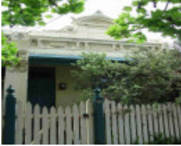
Abbotsford Trenergy Crescent 39.JPG
