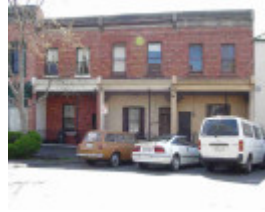
Fitzroy Kerr Street 73-77.JPG
