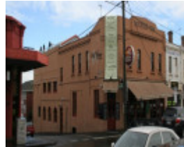
Bridge Rd 68-70 10203.JPG
