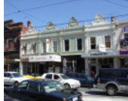
Bridge Rd 38-44.JPG
