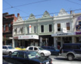
Bridge Rd 38-44.JPG
