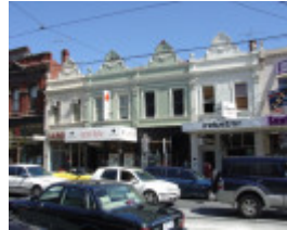
Bridge Rd 38-44.JPG
