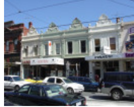
Bridge Rd 38-44.JPG
