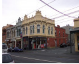
Bridge Rd 53 4692.JPG
