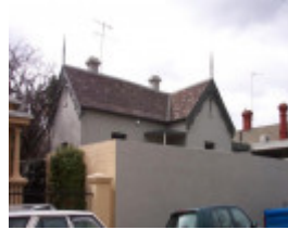
Richmond Tce 5 _6584.JPG
