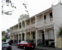
Richmond The Crofts 17- 25.JPG
