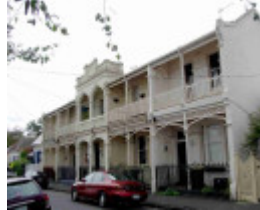
Richmond The Crofts 17- 25.JPG
