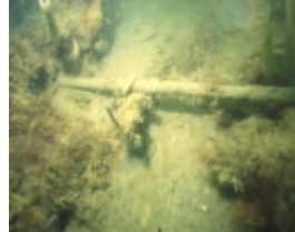
S212 Eleutheria PortPhillipBay Pipe
