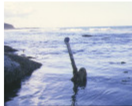
S718 WBGodfrey Lorne PipeInWater
